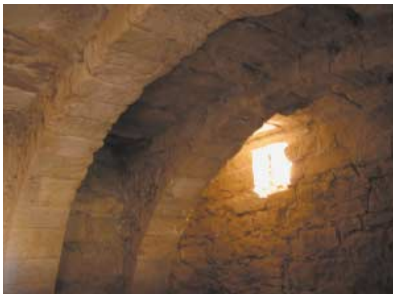
בור נקרות בנגב על דרך הבשמים. הבור בנוי ותקרתו עשויה לוחות אבן המונחים על גבי קשתות
