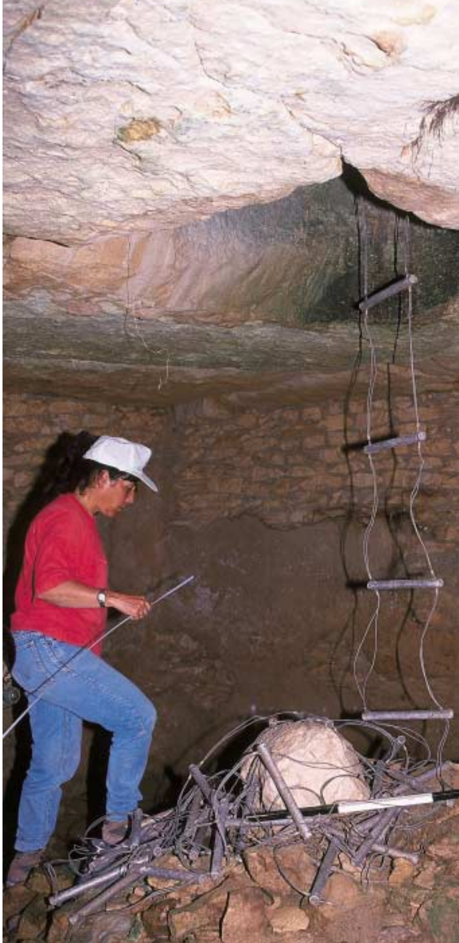
אחד מבורות המים שנבדקו בסקר בשבטה. ברקע, דופן הבור המצופה בבניית אבן ועליה שכבת טיח
