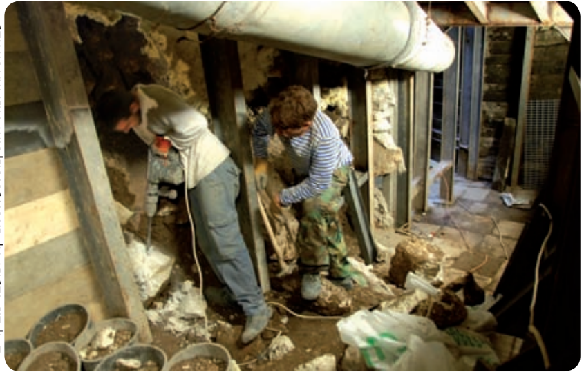
עבודות אחרונות להתקנת תעלת הניקוז למעבר מכרים
