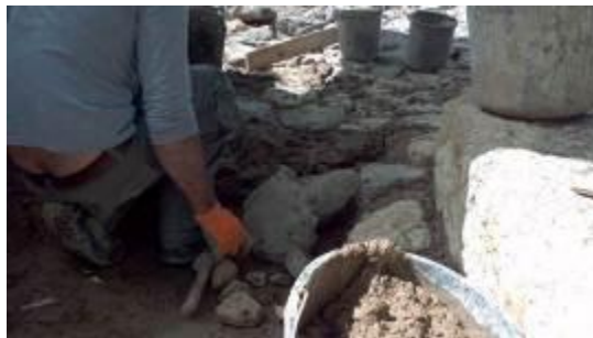
איור 10 : שימור הריצוף.
