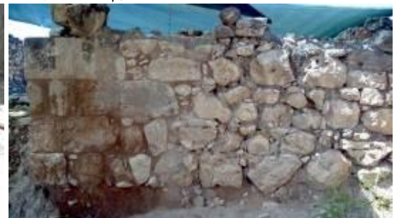
איור 9 : קיר מצפון לשער, מבט ממזרח
